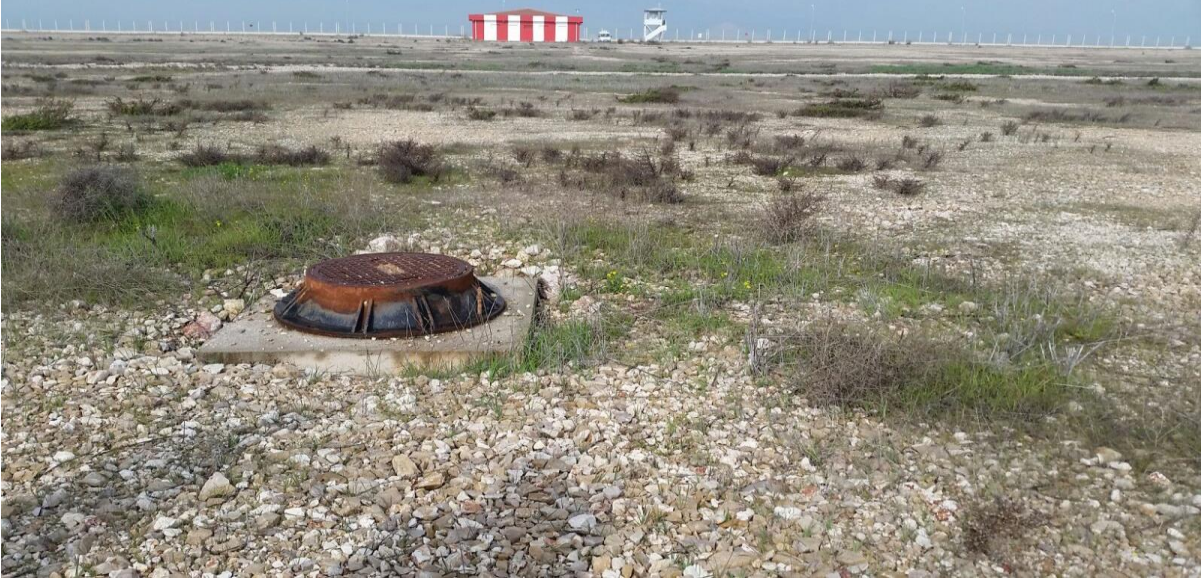
FOTOĞRAF:1 ŞERİT SAHA ELEKTRİK ROGAR BETON KAİDE VE KAPAĞI
